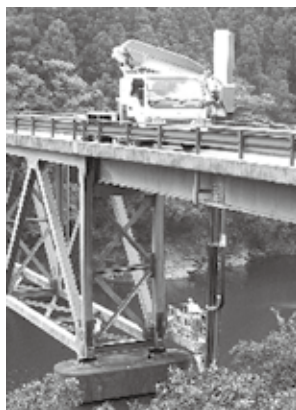
▲点検車両による橋梁の点検
