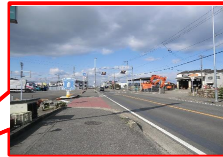
壬生川631-3先路上(国道196号) 2件発生
