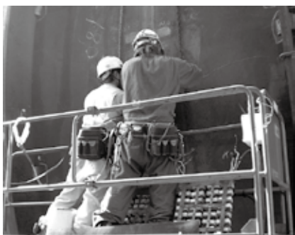
▲現地での局部熱処理作業
