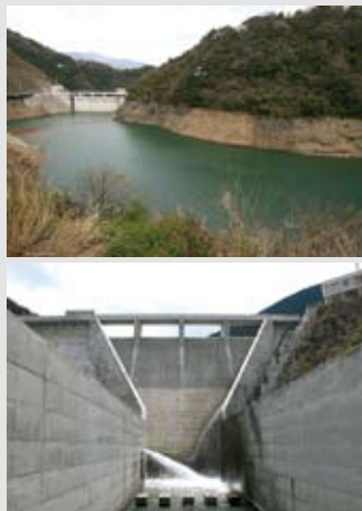
▲ダム湖(上)と高さ48mもある堤体
