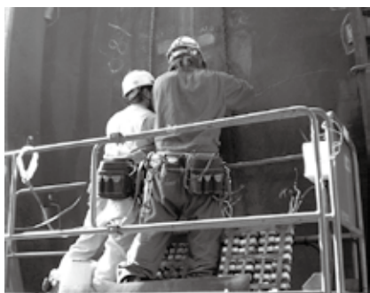
▲現地での局部熱処理作業
