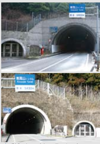
▲愛媛(上)・高知両県のトンネル入口
