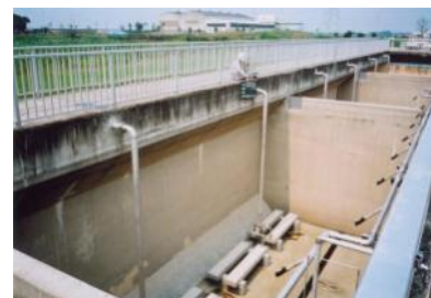
西条浄化センター水処理施設の増設
