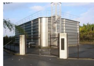
供用を開始した半田山配水池
