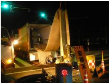
汚水幹線管渠の改築(管更生)工事
