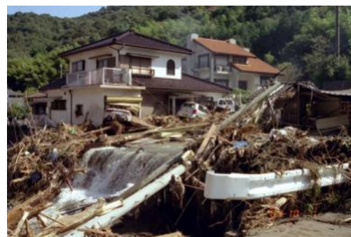
平成16年災害による被害
