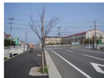
改良が完了した西条駅前干拓地線
