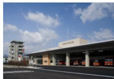
建て替え移転した西消防署
