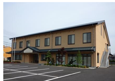
新しくなった大町公民館
