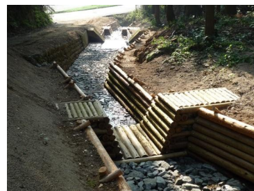
新たに完成した木製ダム
