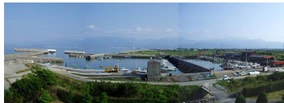
整備が完了した河原津漁港
