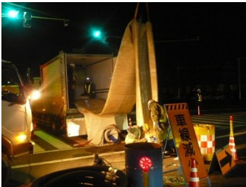
汚水幹線管渠の改築(管更生)工事
