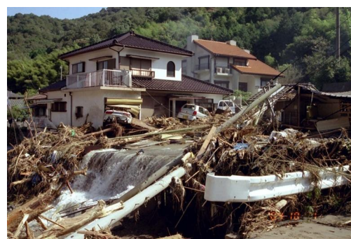
平成16年災害による被害
