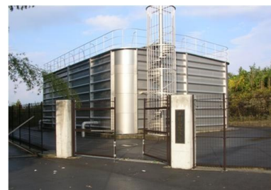
供用を開始した半田山配水池
