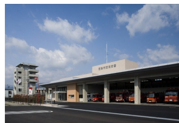
建て替え移転した西消防署
