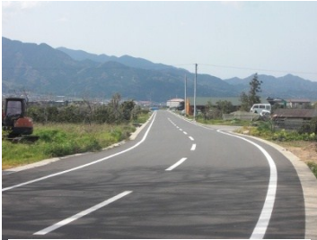
部分供用を開始した柚ノ木線
