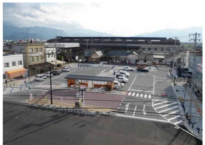
整備が完了したJR壬生川駅前広場
