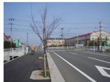
改良が完了した西条駅前干拓地線
