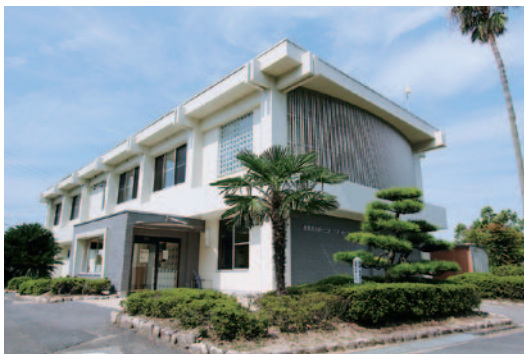
青少年センターを改修し、整備したスポーツコミュニティセンター
