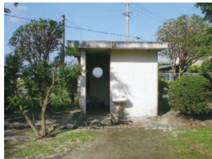
改修前の三芳公園便所棟
