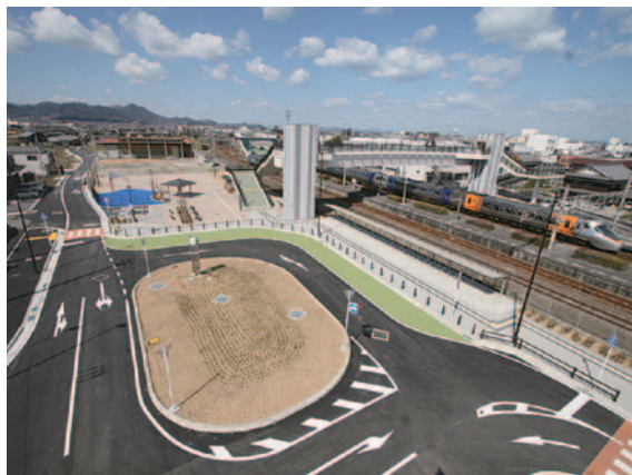
JR 壬生川駅西広場
