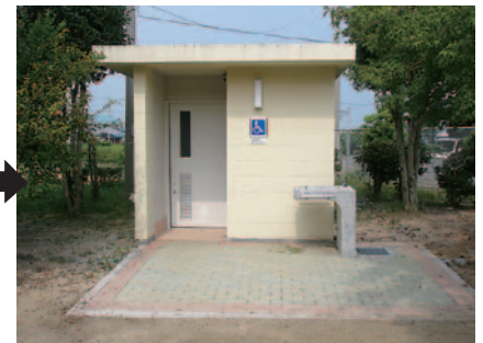
多機能便房やバリアフリー化された身近な公園の三芳公園便所棟
