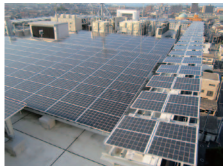
市役所（新館）屋上の太陽光発電システム
