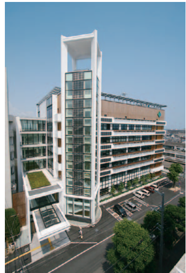
市役所（新館）に設置の太陽光発電システム全景
