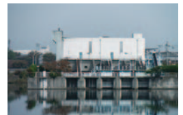
唐樋雨水ポンプ場
