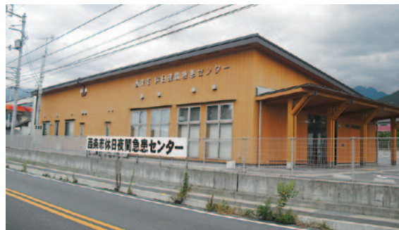
一次救急の拠点として整備された 西条市休日夜間急患センター
