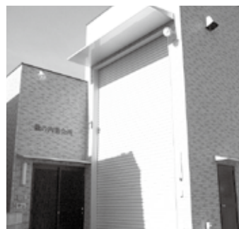
▲完成した藪の内集会所
