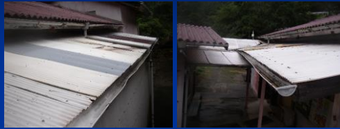
波板の修理・雨どいの清掃
