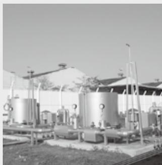
▲工場排熱で温水を作る熱交換器
