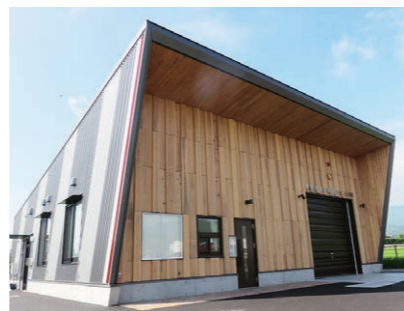
完成した西消防署河北出張所
