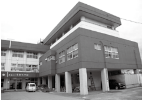
▲小学校校舎等耐震改修事業
