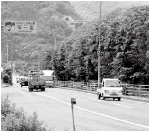
▲国道11号桜三里、湯谷口付近（上方奥は松山自動車道）
