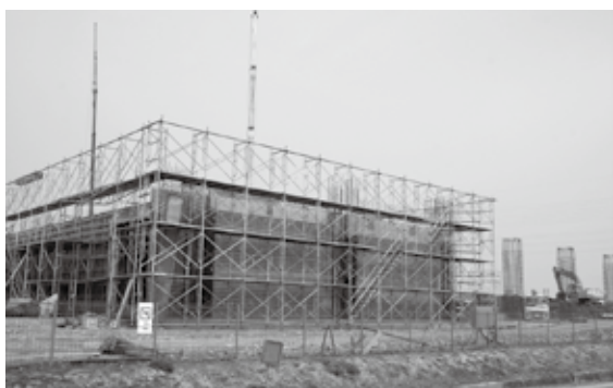
合宿都市構想、スポーツに親しむインフラ整備の一環として建設が進められる東予運動公園の屋内体育施設。
