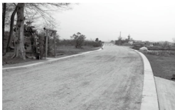
幹線道路の早期実現を要望するとともに、道路改良事業を推進していきます。(写真は現在整備中の市道柚ノ木線)
