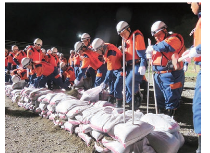
「積み土のう工」の手順を再確認
