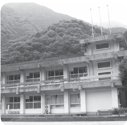
改修予定の加茂公民館
