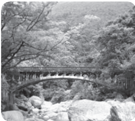
補修予定の大宮橋
