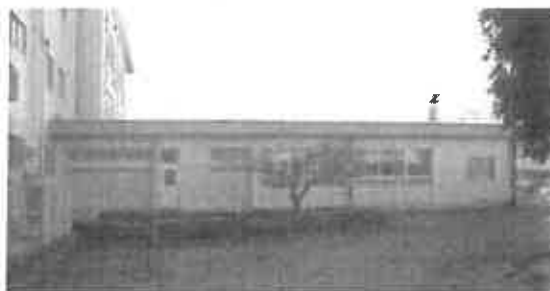
岩舟小学校給食調理場 （左：外観 右：調理と洗浄が同じ区域で近接している）
