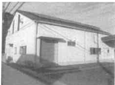
栃木第四小学校給食共同調理場
