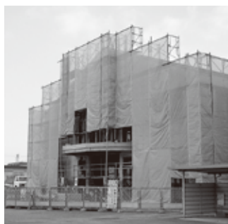
順調に工事が進捗している丹原公民館
