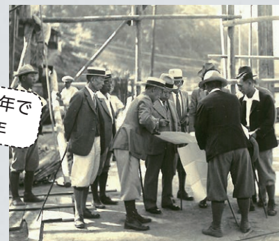
▲工事現場での打ち合わせの様子
