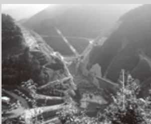
▲ダムコンクリート打設前
