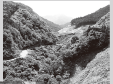
▲着工前の志河川ダム建設現場
