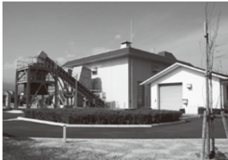
▲本河原ポンプ場建設事業
