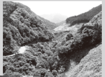
▲着工前の志河川ダム建設現場
