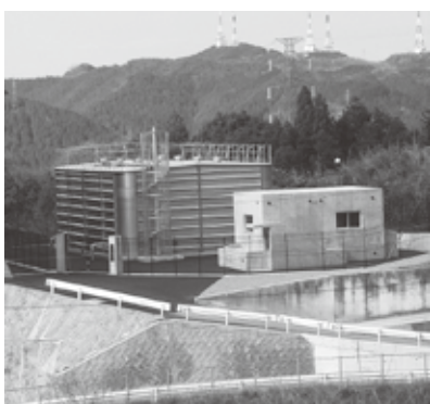
東部地区上水道高区配水池
