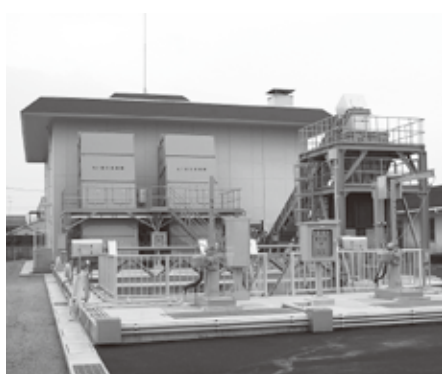
本河原雨水ポンプ場
