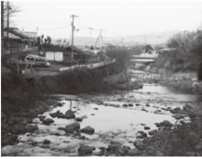
渦井川にある第一井堰
