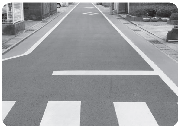
舗装打ち替え後の通学路
