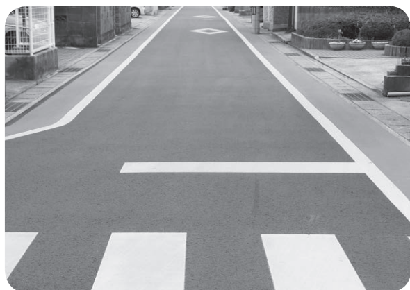
舗装打ち替え後の通学路
