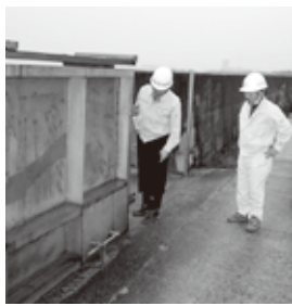
金属製資材等の盗難防止のため県と市では建設業協会と連携してパトロールを行っています。
