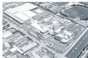
▲完成時の工場の航空写真
