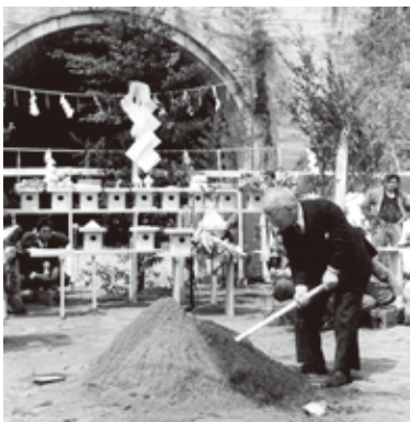
▲新丹那トンネル熱海側入口で挙行された東海道新幹線起工式での十河氏。
