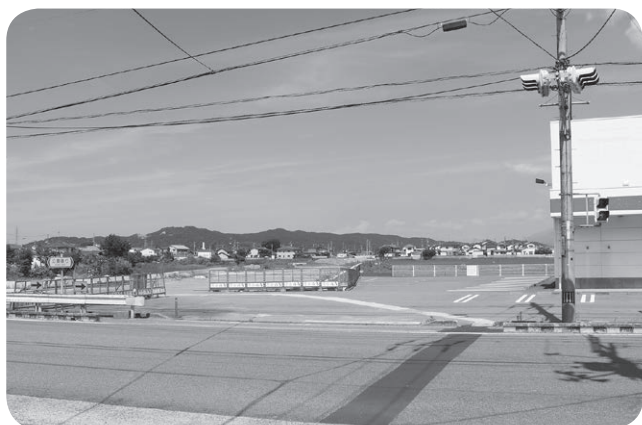
工事中の市道古川玉津橋線
