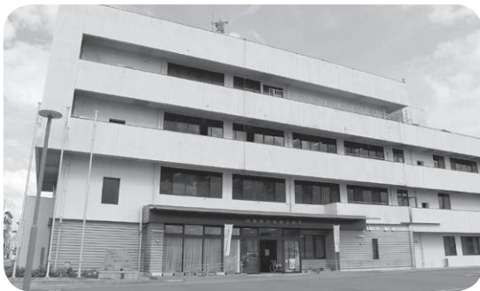
小松総合支所
