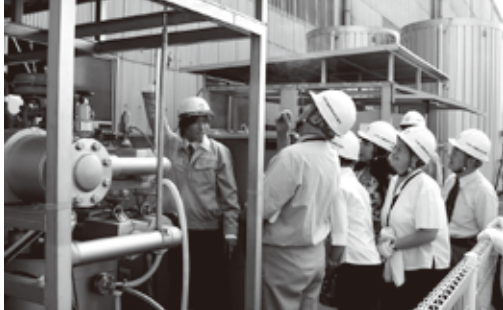
MH冷凍システムを見学する視察団一行
