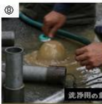
洗浄用の鋼管に交換する
