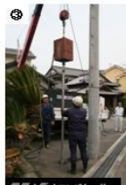
鋼管+ポンプ+コンプレッサー
