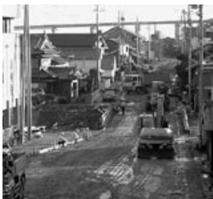
▲台風が過ぎ、一夜明けた妙之谷川橋付近。濁流で家屋が壊滅し、徳永さんをはじめ多くの人が被災生活を余儀なくされた。
