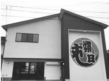
▲完成した朔日市西集会所
