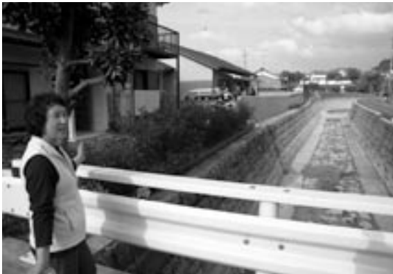
▲山田さんの自宅前には長谷川が流れる。普段は雨が降っても少量の水しか流れない川だが、当時は数分間で、ごう音と共に水と流木が押し寄せてきた。写真左は山田さん。
