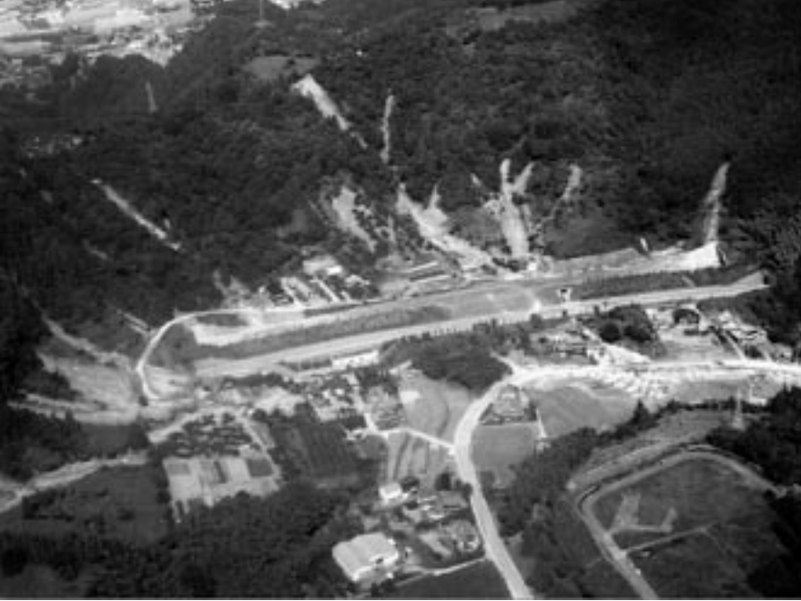
▲平成16年9月29日の台風21号によって、数多くの山々が崩落しました。（写真は中寺地区）
