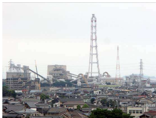
臨海部の工場設備
