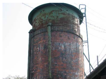
伊予西条駅レンガ給水塔
