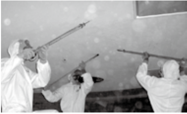
アスベスト除去工事の様子
