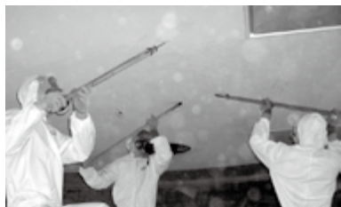
アスベスト除去工事の様子
