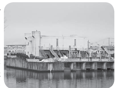
ポンプ増設工事を実施している唐樋ポンプ場(朔日市)
