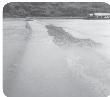
冠水する地藏原地区(平成29年10月)
