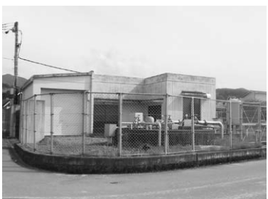
▲昭和63年に改修の南川水源地
