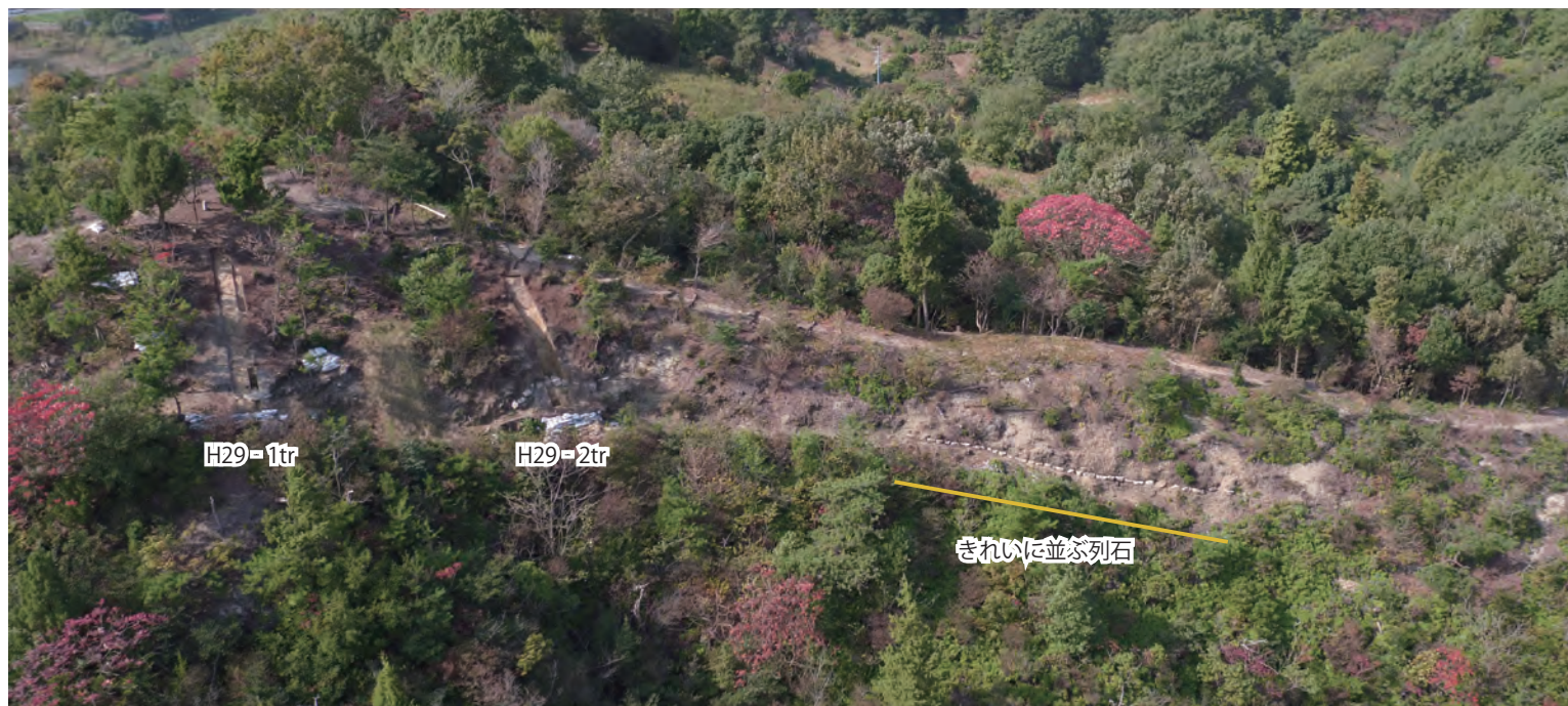
城壁調査・整備の進む南東部尾根
